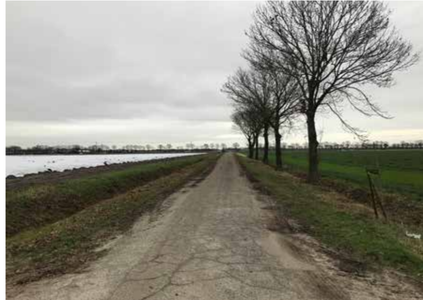
2. Noord-westelijke hoek thv Schorfweg kijkend naar Oosten. Opvallend hier is de bomenrij die een deel van de Schorfweg vervolgt maar na enkele meters afgekapt wordt. Daarna is er vrij zicht over de velden.
